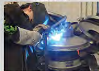
Soudage de la Pile de Tête de Bobine
