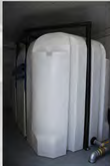
740 Réservoir d'eau Gallon (De Face)
